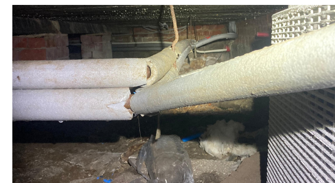
Afval & airco in de kruipruimte
