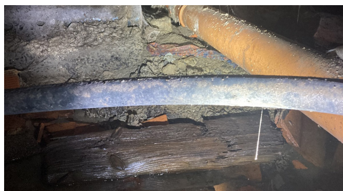
Houten balken in de kruipruimte
